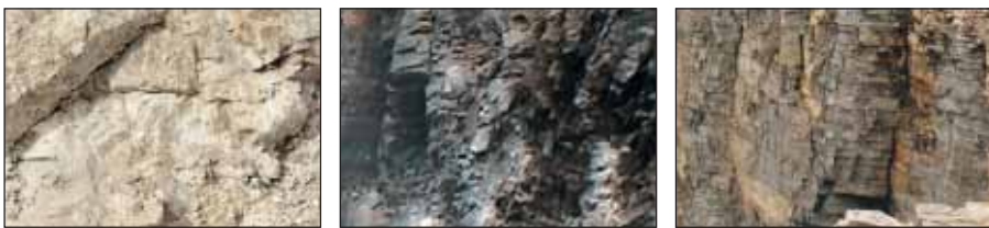
Çatlaklı kaya oluşumu
